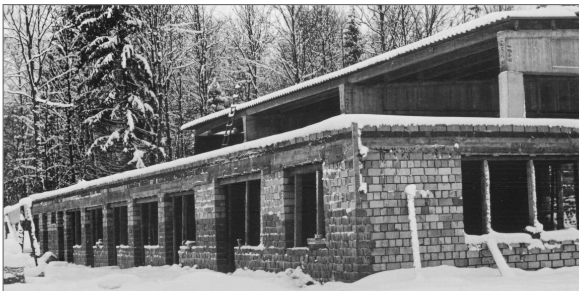
Im Herbst 1964 stand der Rohbau.
