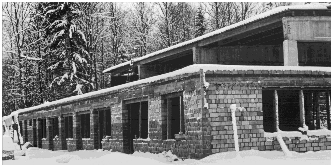
Im Herbst 1964 stand der Rohbau.
