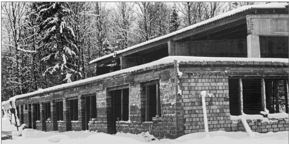
Im Herbst 1964 stand der Rohbau.
