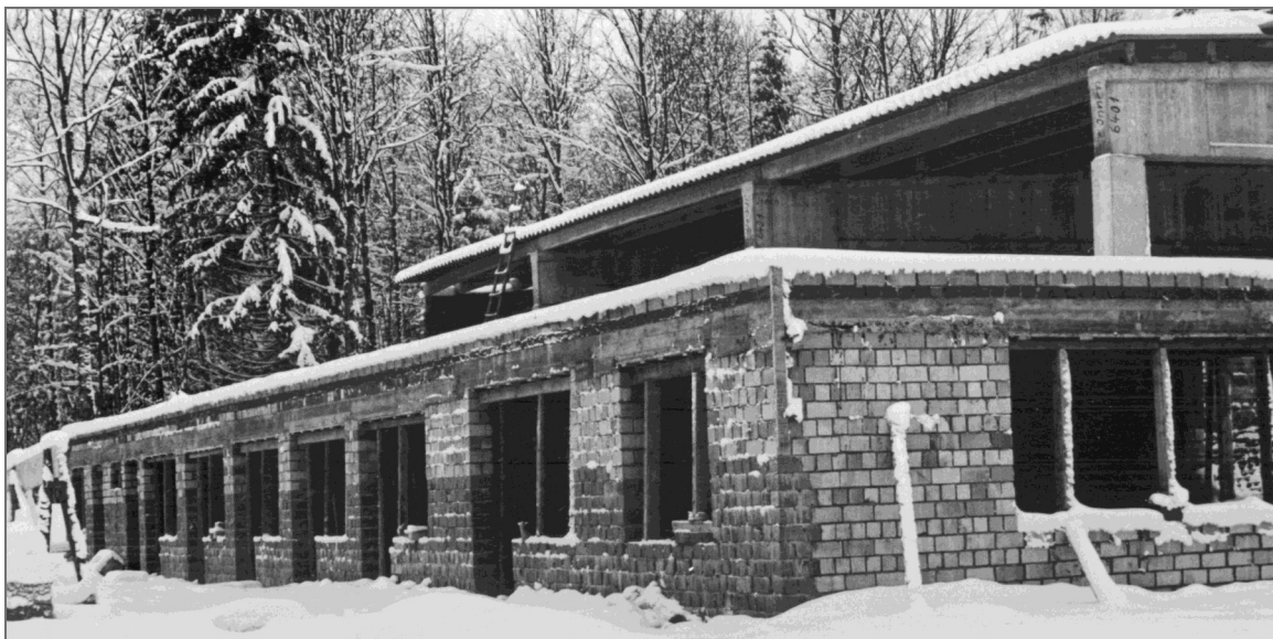
Im Herbst 1964 stand der Rohbau.
